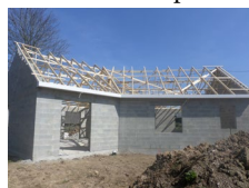
Pose de la charpente
