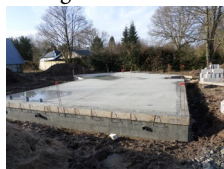
Coulage des fondations
